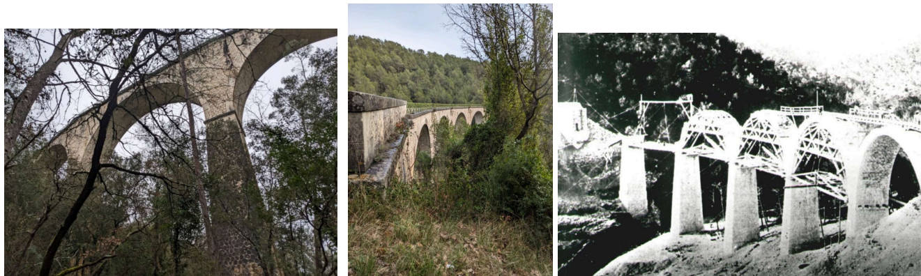
Construction du viaduc
