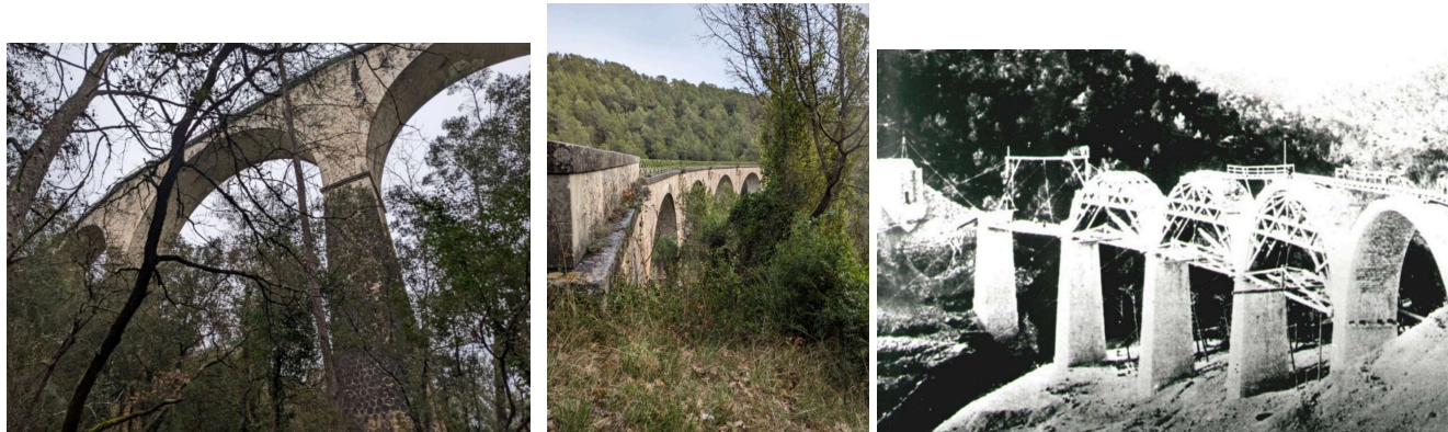
Construction du viaduc
